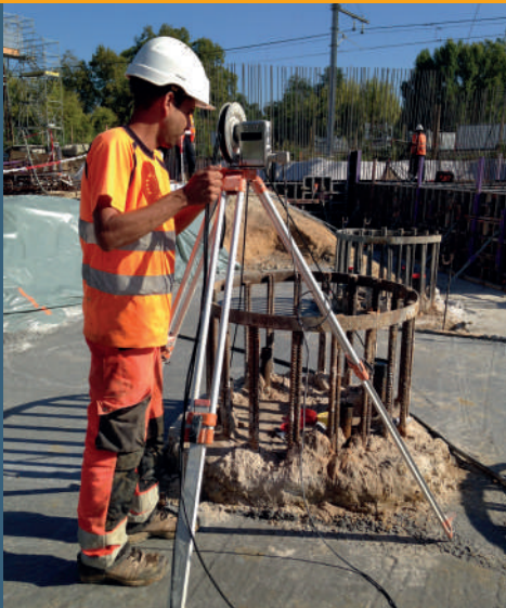
Contrôle d'homogénéité du bétonnage de fondations profondes par des essais soniques
