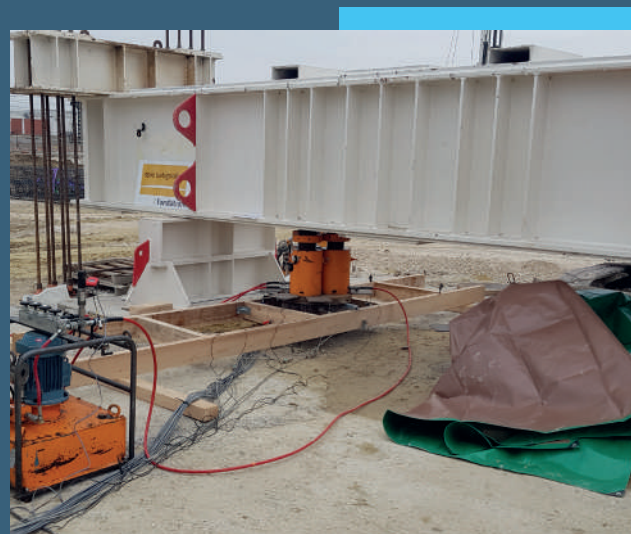
Essai de chargement sur pieu
